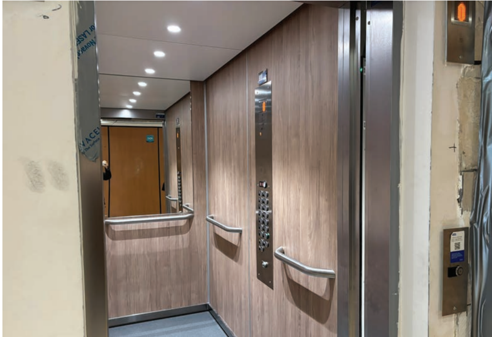
Nouvelle cabine d'ascenseur posée à Châtillon (résidence République), les habillages extérieurs sont en cours de finalisation.
