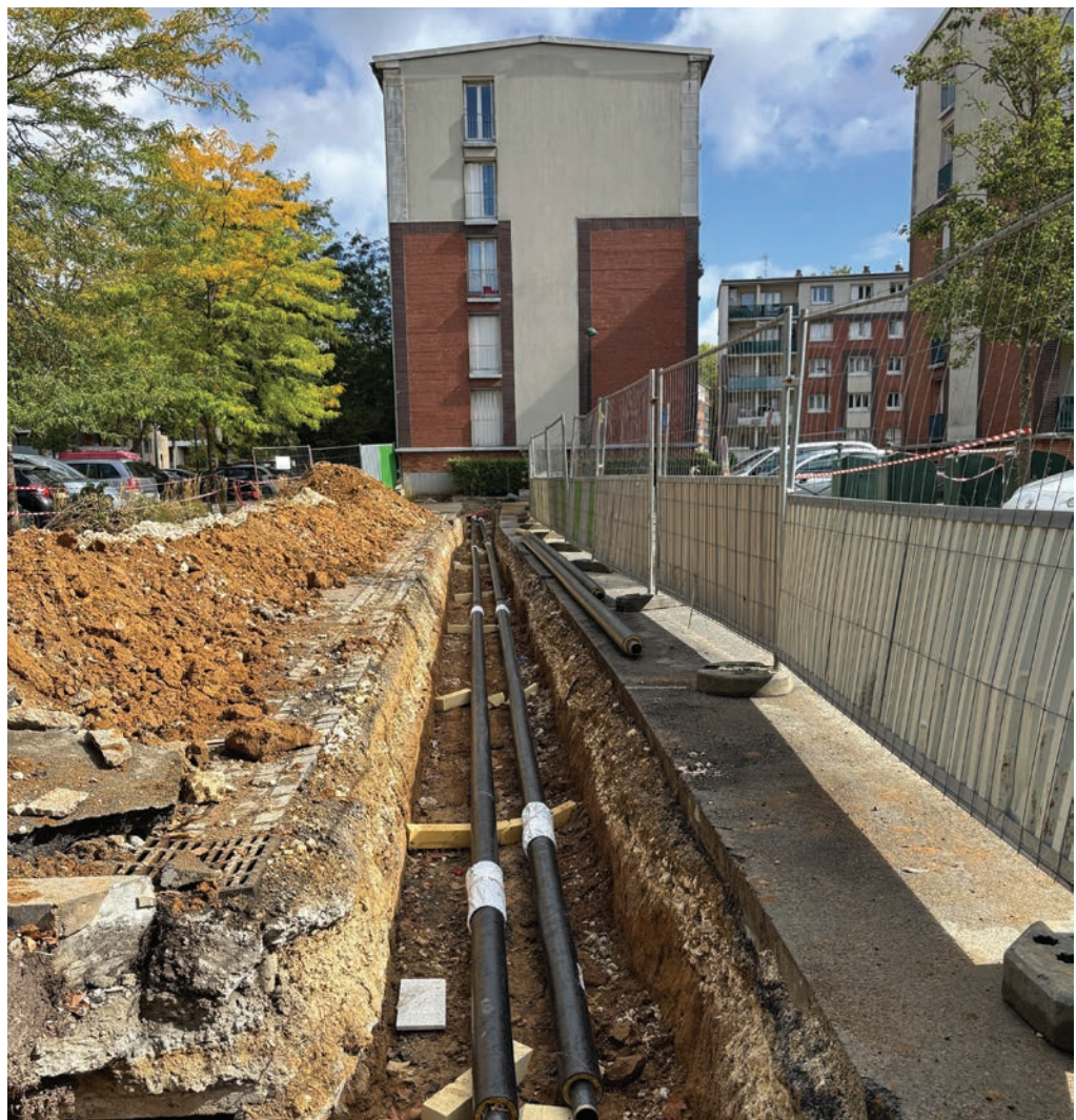
Des tranchées impressionnantes pour moderniser les réseaux de chauffage dans le quartier de Trivaux, à Clamart.
