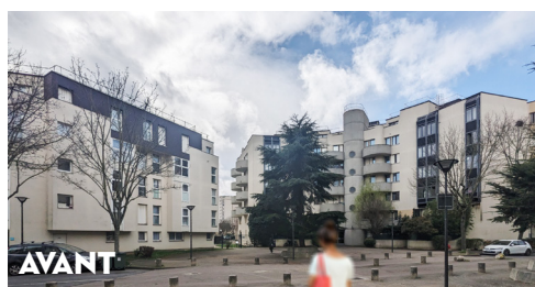
Bâtiment G et F, allée du Cèdre
