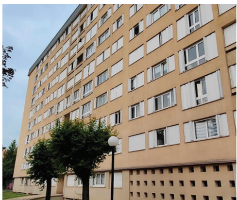
Résidence Gatnot, la façade Est, état actuel.
