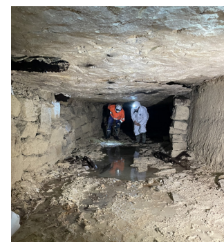
Pour rendre la construction possible, des travaux de renforcement du sol ont été menés sur le site, qui était précédemment une carrière.
