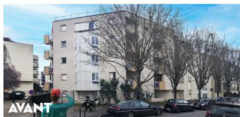
Bâtiments K et J : 5, Allée du Cadran Solaire, vue depuis l'allée
