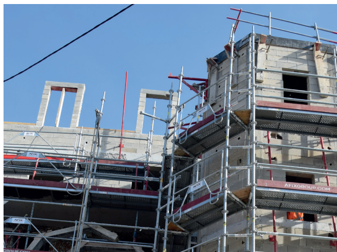
Travaux de réhabilitation du 17 rue Paul-Vaillant-Couturier, Clamart.
