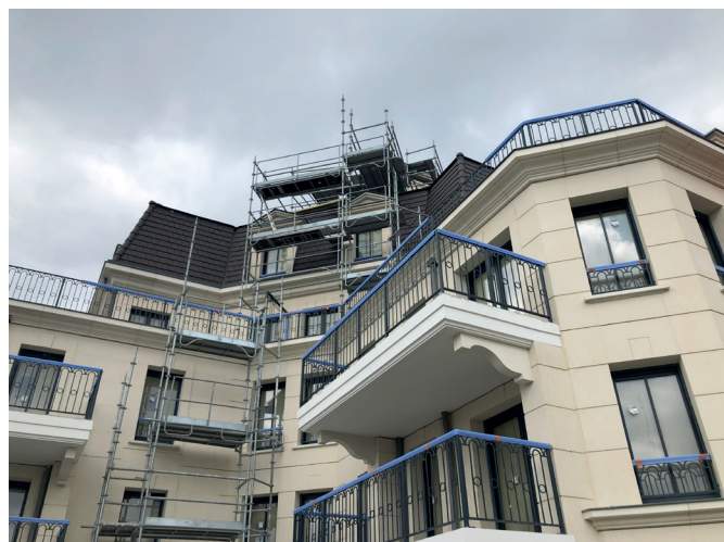
VEFA Campus, livraison de 28 logements, Clamart.
