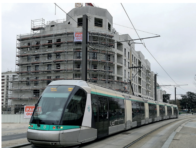
Domaine de La Quintinie à Clamart, en cours de travaux. Livraison 2025
