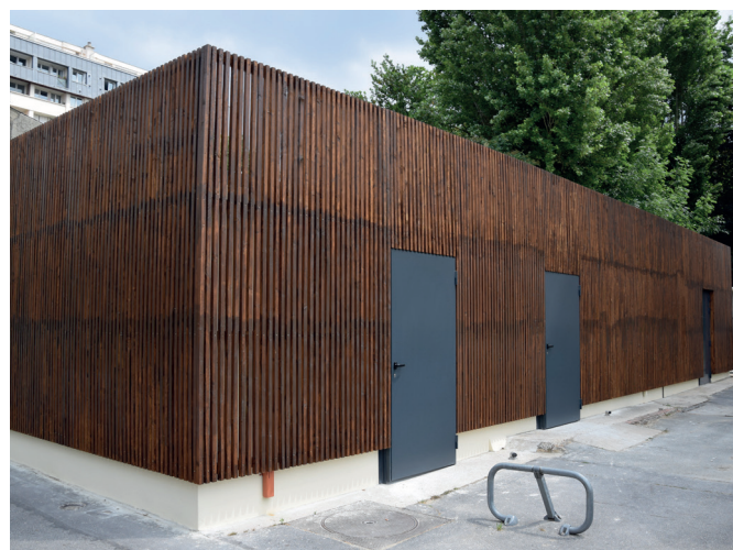
Aménagement d'un espace de tri, résidence Gatnot, Châtillon. Après
