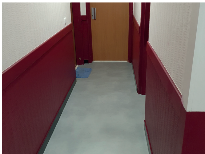
Réfection des peintures de la Résidence République à Châtillon.
