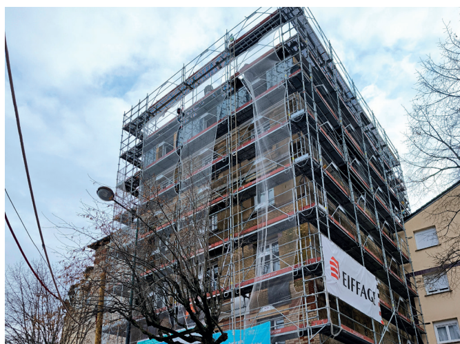
Réhabilitation du 18 boulevard des Frères Vigouroux à Clamart.
