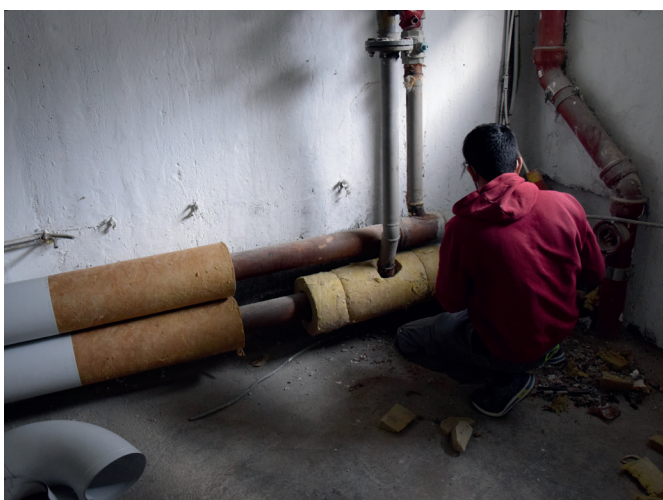
Remplacement des calorifugeages à Trivaux, Clamart.
