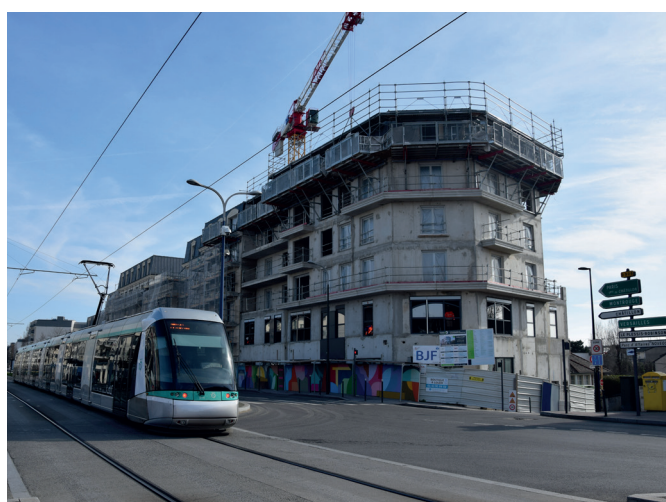
Midi, Clamart. Construction de 27 logements par Bouygues Immobilier. Livraison en 2025.
