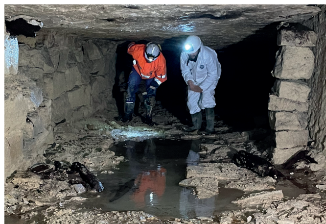
Perthuis, début des travaux d'un ensemble immobilier de 17 logements locatifs et une crèche de 60 berceaux, Clamart. Confortement des carrières.
