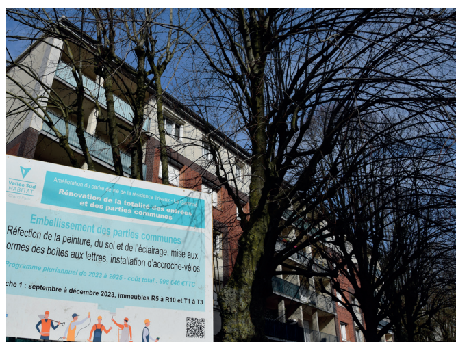
Rénovation des parties communes à Trivaux, Clamart.
