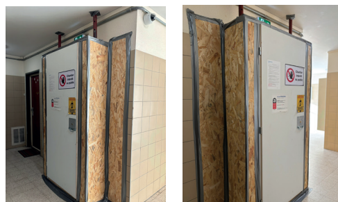
Changement des ascenseurs de la résidence Malakoff à Châtillon.
