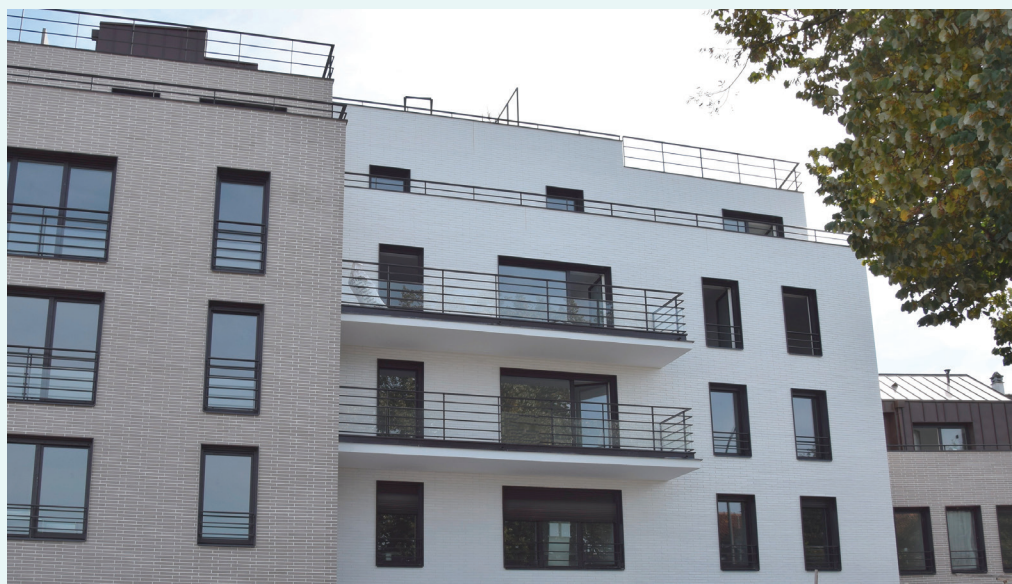
Façade de la résidence Villa Flore à Châtillon.
