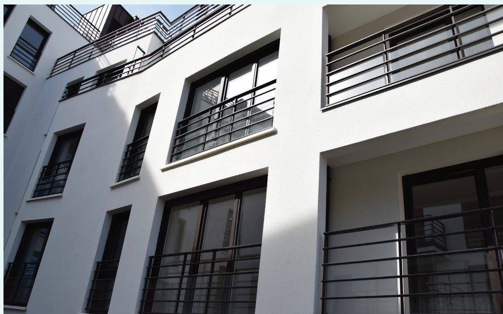
Cour de la résidence Villa Flore à Châtillon.
