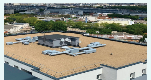
80 000 € ont été consacrés à l'étanchéité et la sécurisation de la terrasse du 23.
