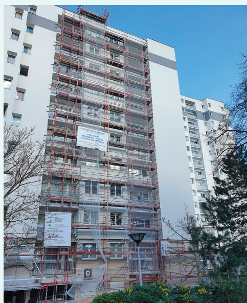
Un immeuble en travaux.
