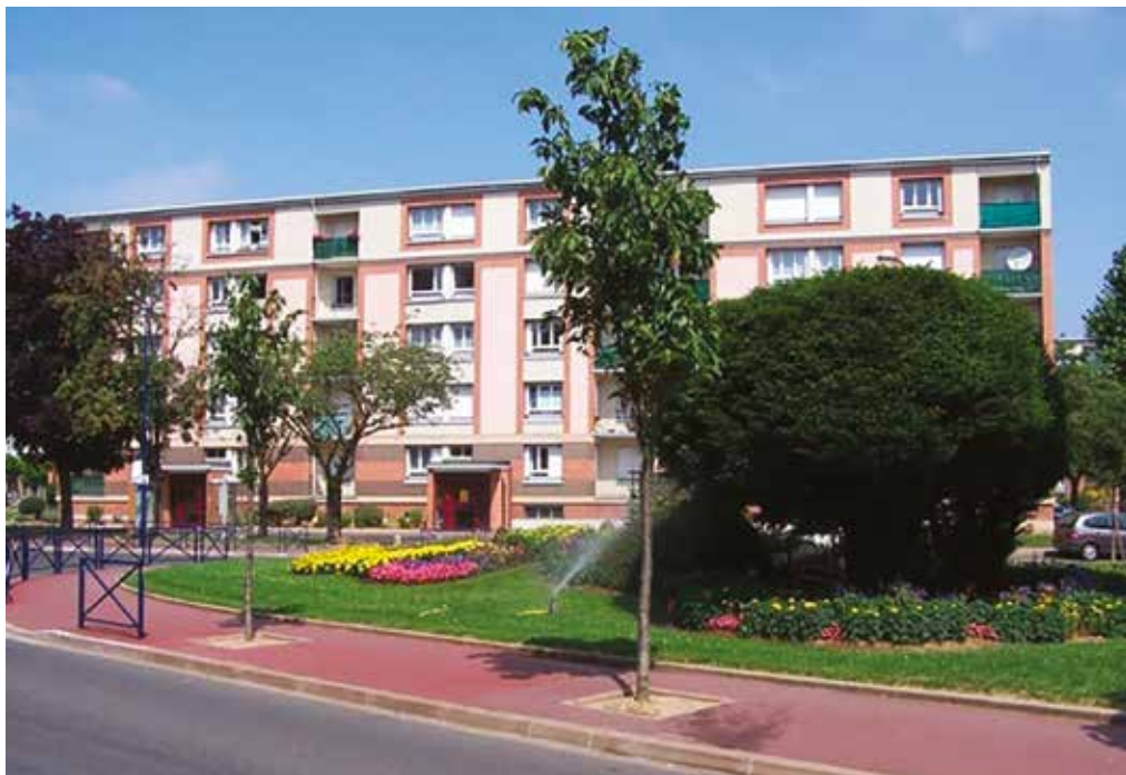
Construite entre 1954 et 1969 sur le plateau de Clamart, la cité de la Plaine propose 1993 logements dont 89 maisons individuelles. Elle fut réhabilitée entre 1995 et 2003.
