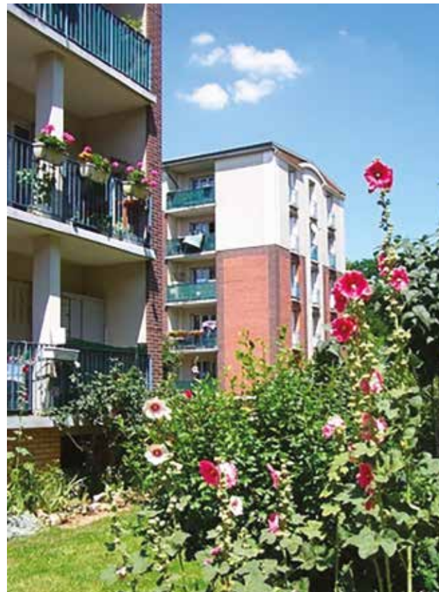
La cité de Trivaux La Garenne, située sur le haut Clamart, fut construite entre 1964 et 1968. Elle connut des ajouts : 142 rue de la porte de Trivaux, 8 logements construits en 1971 et démolis en 2019 ; 136 à 140 rue de la porte de Trivaux, 45 logements construits en 1976 et démolis en 2019.
