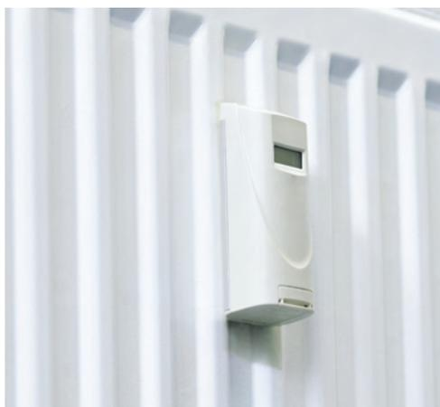
Le répartiteur posé sur chaque radiateur mesure les différences de température entre le radiateur et la pièce et permet d'en déduire la quantité de chaleur effectivement consommée.
